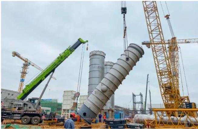
预聚缩塔吊装需从 28 米高空横跨聚合单元向下，且是首次采用 400 吨履带吊装作业，克服诸多困难，圆满完成设备吊装工作，为项目后续开展大型设备吊装工作打下坚实基础。
