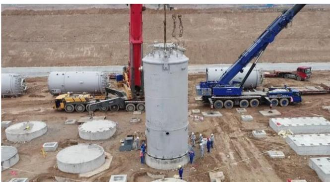
首台炔化反应器的顺利就位，标志着项目正式进入安装阶段，拉开了项目安装施工高峰的序幕。
